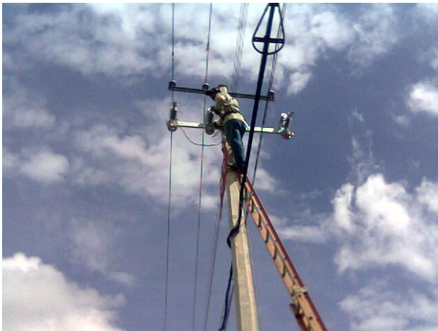
Instalación acometida para subestación 45KVA
