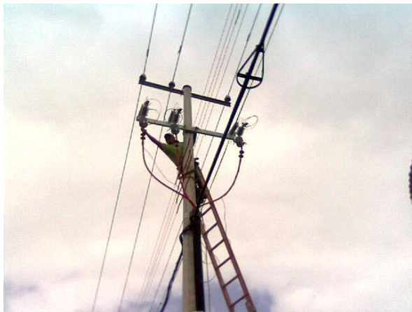
Instalación acometida para subestación 45KVA
